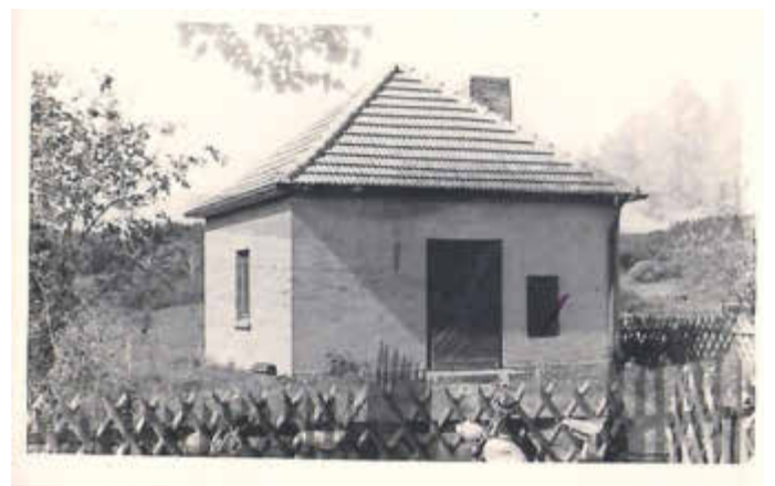
Historische Aufnahme vom Pumpenhaus in der Kastanienallee. Bis dahin lief das Abwasser entsprechend des Gefälles selbstständig. Im Vordergrund steht ein Moped SR 2.
