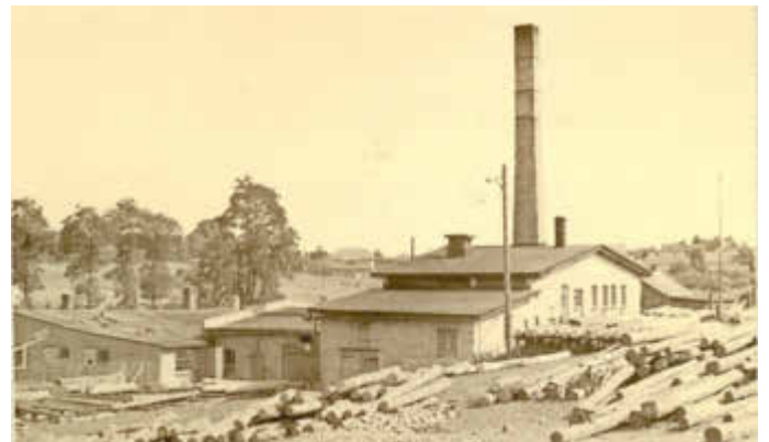
Neue Aufgaben der Firma Greck bestanden in dem Bau der Abwasserentsorgung und der Trinkwasserversorgung Feldbergs.
