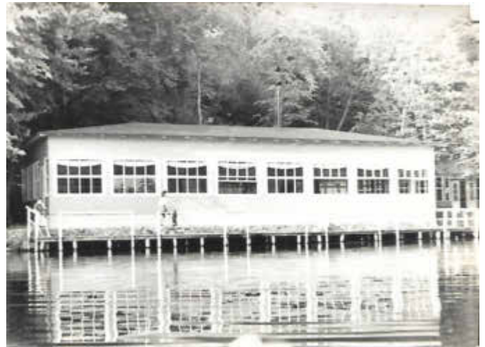
Die große Luzinhalle in der Außenansicht.
