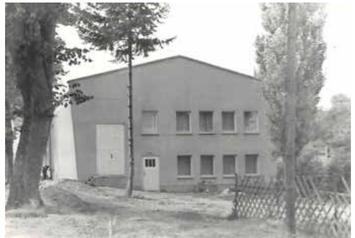
Blick vom Parkplatz auf den Juri. Rückfront des Kulturhauses mit Garderoben. Hinter dem Gebäude befand sich ein Parkplatz. Zu jener Zeit natürlich unbefestigt!
