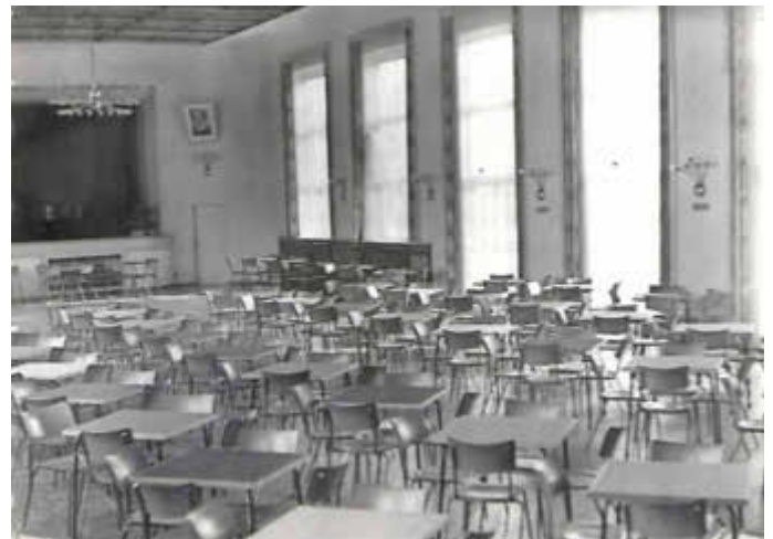
Innenansicht des Saales im Kulturhaus.
