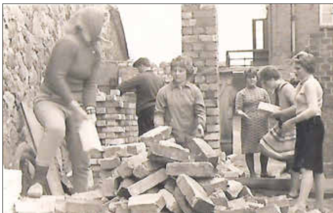
Neubau des Internates mit rund 12 Plätzen in 3 Zimmern, Duschen und einer Toilette
