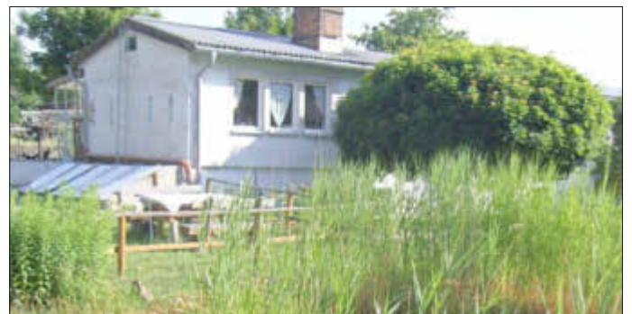
Das Schulgebäude der ehemaligen Sonderschule wurde viele Jahre von der IPSE genutzt.
